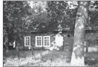
Vor dem Umbau des Heuerhauses
