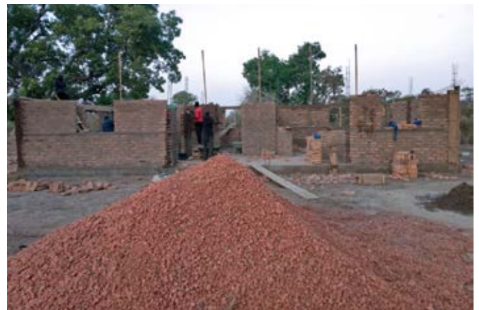
Tschad * Fr.-Wolter-Stiftung * 2023 Gesundheitsstation Kirmi Koro im Bau
