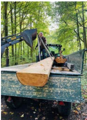
Die schweren Holzelemente konnten nur mit schwerem Gerät bewegt werden.
