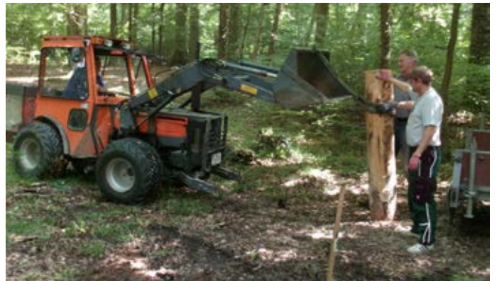
Bild 3: Die Unterkonstruktion wird gesetzt
