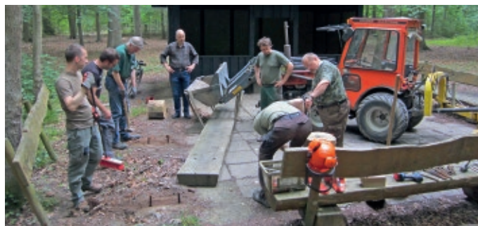
Austausch der Unterkonstruktion
